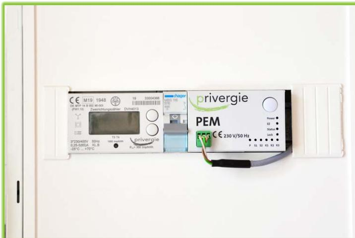
Spannung einschalten. PEM am LS-Schalter einschalten
