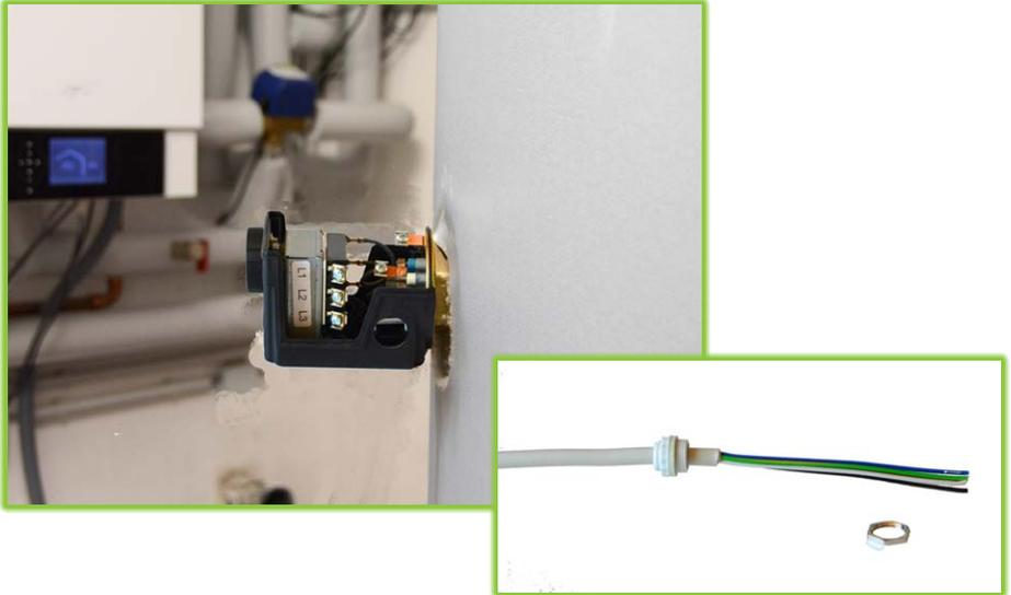
Kabel in Heizstab einfuhren und Tulle festschrauben. Zugentlastung ebenfalls festschrauben.
